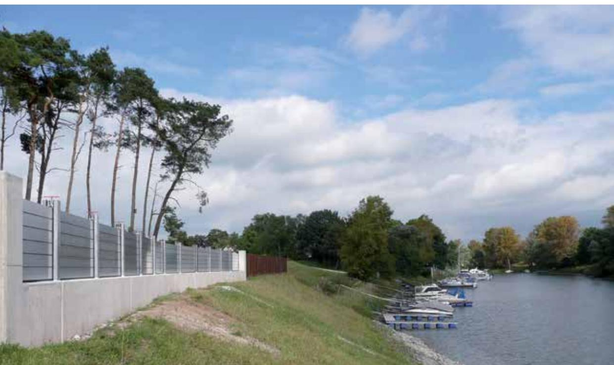
Общий вид шпунта с надстроенными шандорными балками
